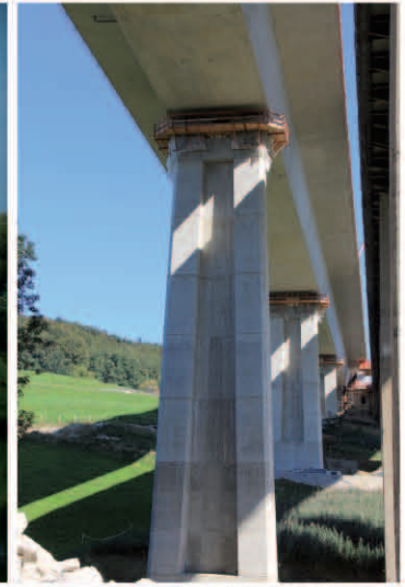
Eisenbahnüberführung Übersee Feldwieser Str.
